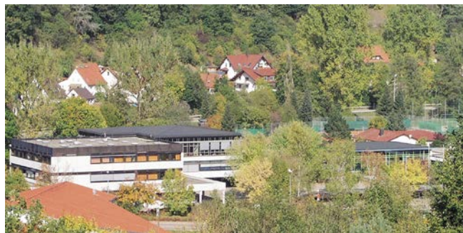
142. Grund-, Haupt-, und Realschule Abtsgmünd: „Schule kompakt“. Mit 692 Schülern in drei Schularten (Stand 2004) ist die Friedrich-von-Keller-Schule (GHRS) Abtsgmünd eine Mittelpunktschule im ländlichen Raum des Ostalbkreises – mit einer Dreifeldsporthalle, verschiedenen Sportanlagen und einem Hallenbad in unmittelbarer Nachbarschaft.
