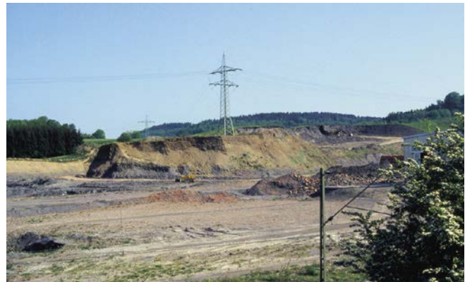
186. Essingen, Tonabbau des ehemaligen Ziegelwerks Trost
