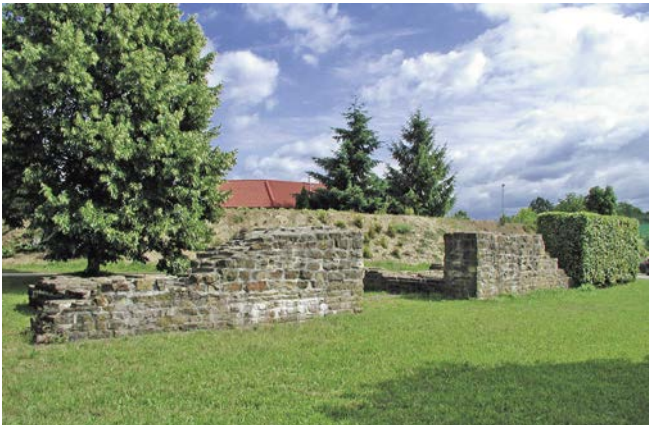
298. Böbingen, konservierte Ruine des römischen Kastelltores
